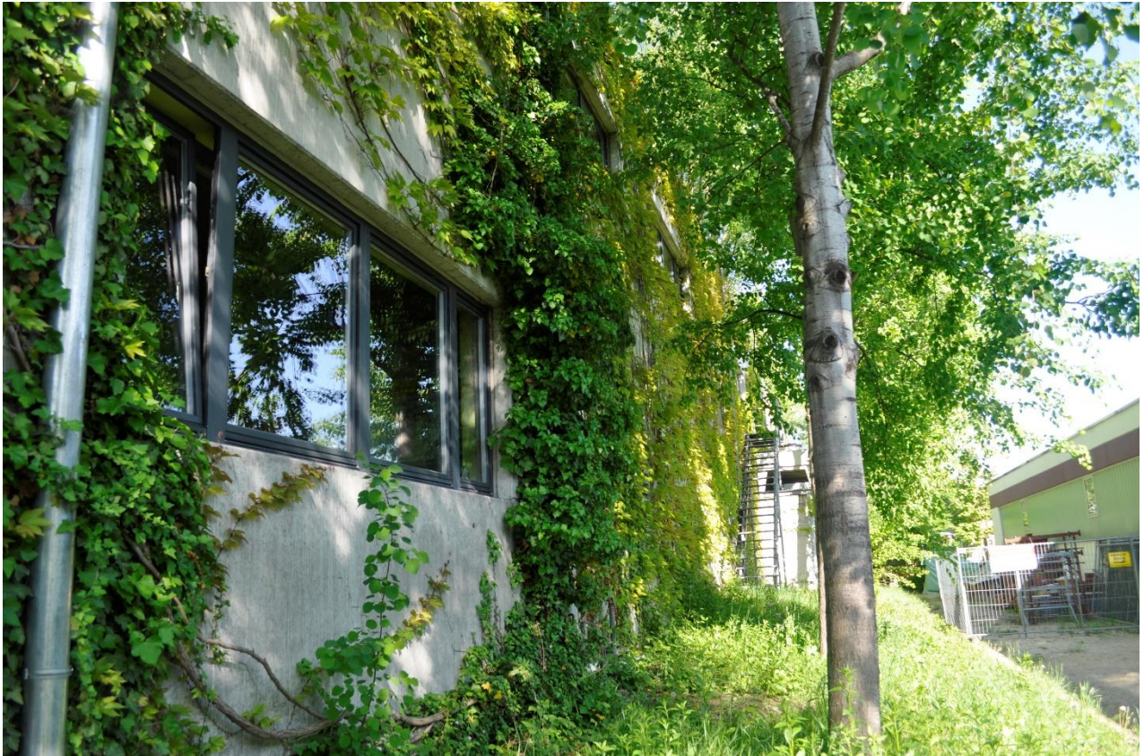
Oben: Selbstklimmende Fassadenbegrünung in Kombination mit Beschattung durch Bäume als Teil eines Gebäudeklimatischen Konzepts beim Fruchthof Konstanz
