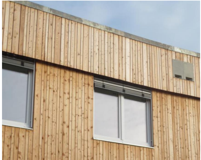
Oben: Fassadenintegriertes Winterquartier für Fledermäuse Unten: Mauerseglerkästen in Wärmedämmung integriert Quelle: Umweltamt Dresden (April 2016) https://www.dresden.de/media/pdf/umwelt/Nisthilfen.pdf
