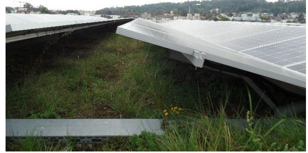
Kombinationen extensives Gründach mit PV/ Fotos Bodensee-Stiftung
