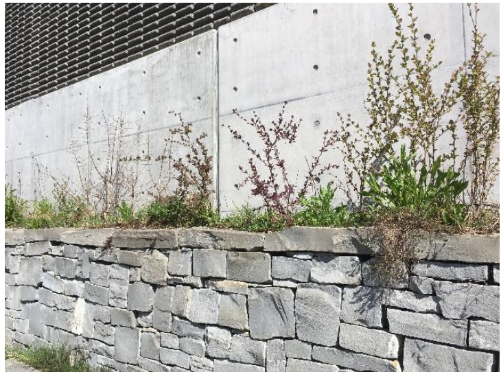
Trockenmauer Bahnhof Rankweil/ Foto: Bodensee-Stiftung
