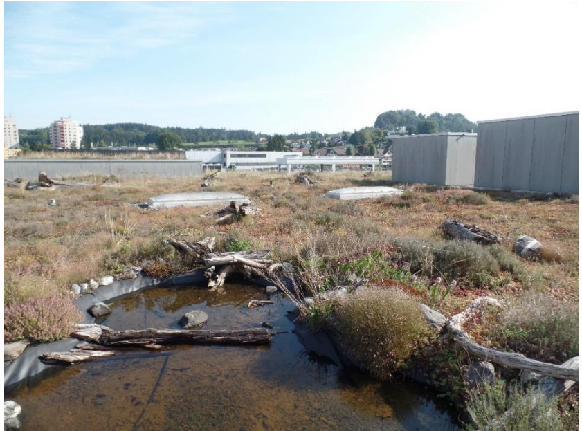
Biodiversitätsförderndes Gründach Migros, Ostschweiz/ Fotos: Bodensee-Stiftung
