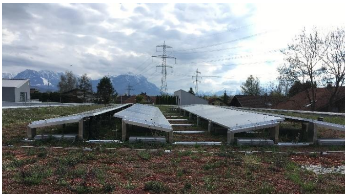
Links: Solargründach, rechts Extensivgründach als Aufenthaltsraum bei Omikron, Vorarlberg/ Fotos Bodensee-Stiftung
