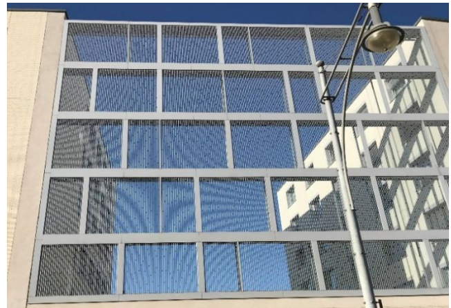
Vogelsichere Lärmschutzwand/ Foto: Bodensee-Stiftung
