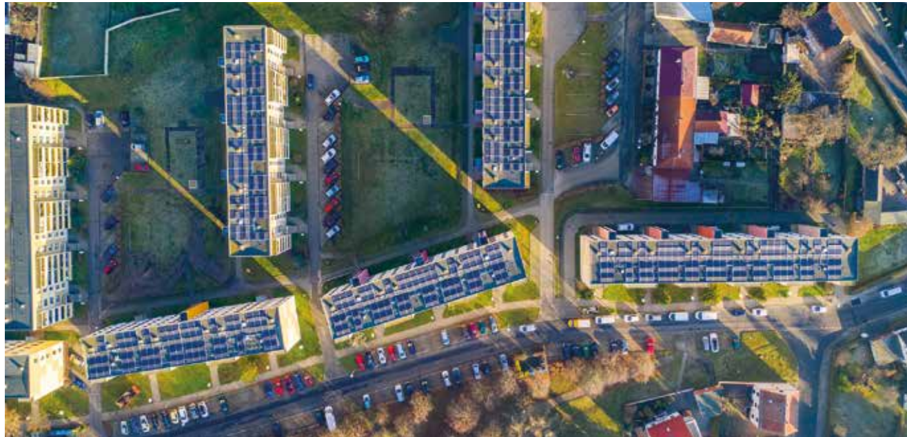
BPV-Strom Nutzung in allen Sektoren ist Ziel des CSSC Labs. Der selbst erzeugte Strom kann auch für E-Mobilität und Wärmeerzeugung (z.B. mit Wärmepumpen) verwendet werden.
