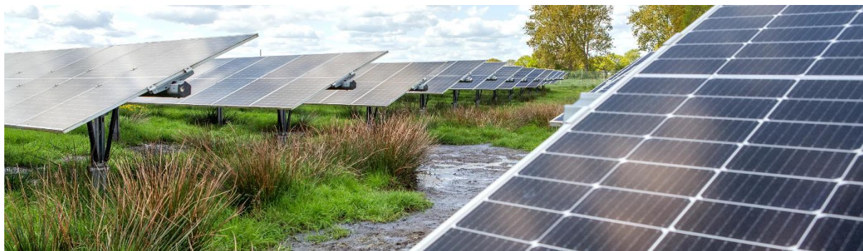
Abbildung 3: Beispiel für eine PV-Anlage mit Wiedervernässung in Lottorf im Kreis Schleswig-Flensburg. Das Unternehmen Wattmanufactur hat die Anlage 2021 auf zuvor intensiv landwirtschaftlich genutztem Moorboden gemäß einem Konzept zur Wiedervernässung realisiert und betreibt sie. (Bildrechte © Wattmanufactur, https://wattmanufactur.de/image/best-practice/lottorf/energie-pano-lottorf.webp )
