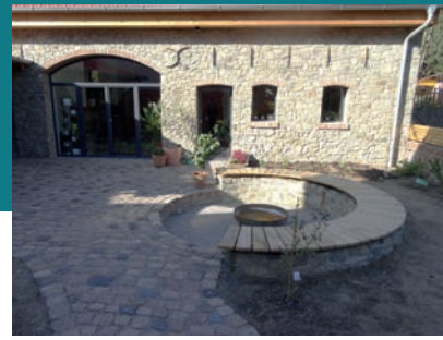
Die Pflastersteine im Hof stammen von einer alten Straße in einer anderen Gemeinde: Von Hand aufbereitet und wiederverwendet. Foto: Landkreis Darmstadt-Dieburg
