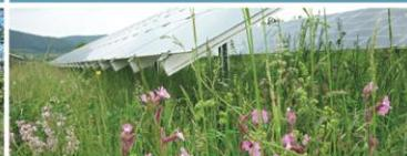
Um möglichst wenig Fläche zu versagen, empfiehlt es sich, die Module zu rammen. Ein Beweiss ist mit ausreichendem Platz zum Boden und zwischen den Modulen gut möglich und Pflege- und Wartungsarbeiten werden erleichtert.
