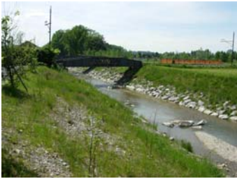
Goldach im Unterlauf nach der Sanierung 2008
