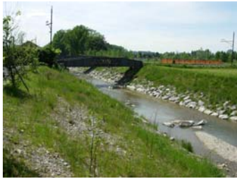
Goldach im Unterlauf nach der Sanierung 2008
