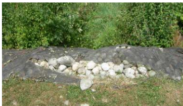
Steinwall mit Vlies auf Hafemole
